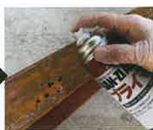
専用プライマーを塗布
